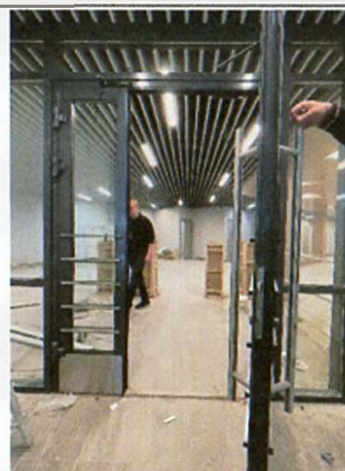
Фото 2. На стеклянном полотне входной двери, отсутствует контрастная маркировка. Двери с доводчиком, не обеспечивают задержку закрывания, продолжительностью не менее 5 секунд
