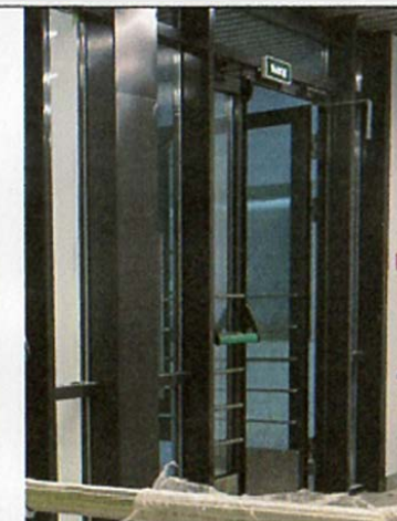
Фото 2. На стеклянном полотне входной двери, отсутствует контрастная маркировка. Двери с доводчиком, не обеспечивают задержку закрывания, продолжительностью не менее 5 секунд
