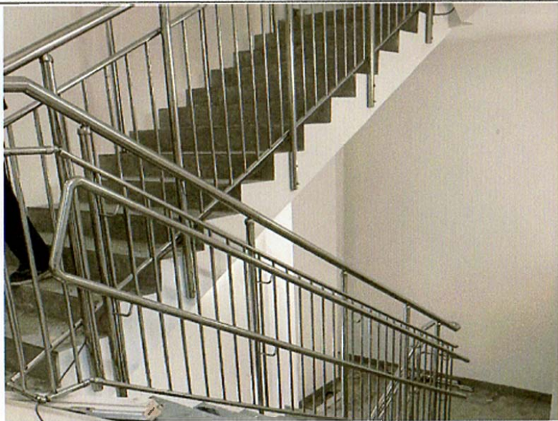
Фото 7. Отсутствуют тактильные информирующие обозначения на поверхности поручней при движении по лестнице
